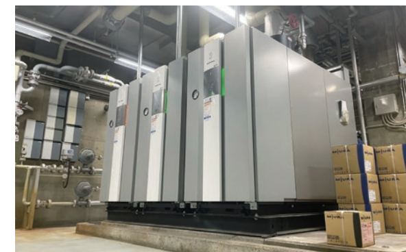
高効率ボイラーへの更新
